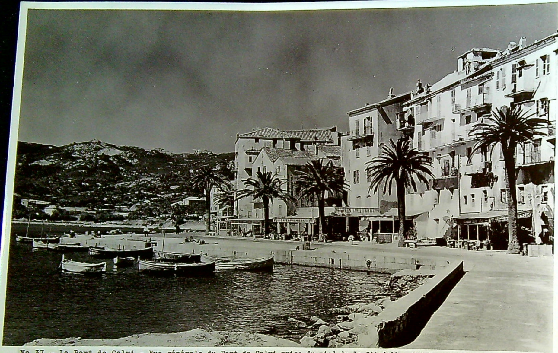
No 37 - Le Port de Calvi - Vue générale du Port de Calvi prise du pied de la Citadelle. Calvi revendique l'honneur d'être la Patrie de Christophe Colomb. La maison où il serait né a été presque entièrement détruite lors des combats de la dernière guerre.
